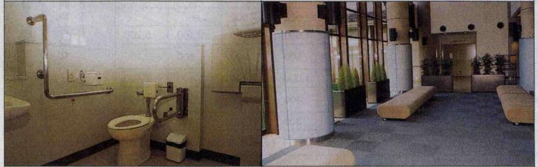
多目的トイレ 車いす専用トイレとオムツ替えシートがあります
