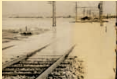
昭28.9 宇治川左岸の堤防の決壊により巨椋池干拓地一帯が浸水(現在の近鉄京鞍線、小倉駅付近)
