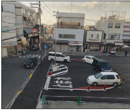
駅前広場(西口)暫定整備
