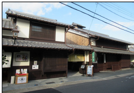
茶問屋(景観重要建造物)
