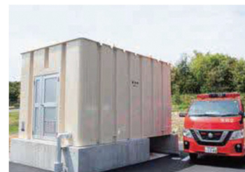
▲10t 耐震性飲料型貯水槽 （玉野市消防庁舎・防災センター）
