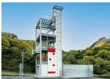
▲訓練棟 (玉野市消防庁舎・防災センター)
