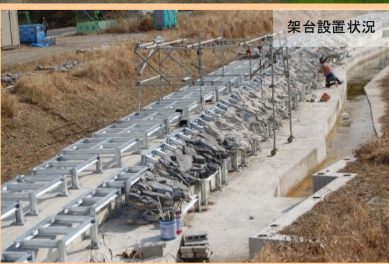
GRCパネ設置(一部試験塗装)
