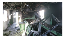
リチウムイオン電池の発火が原因で、リサイクル工場が燃焼してしまった事例(公刊)日本電機産廃リサイクル協会調べ
